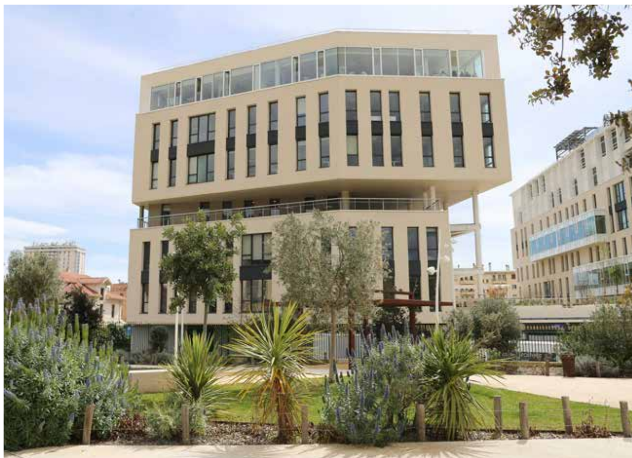
Vue du bâtiment depuis le parc de la Loubière
