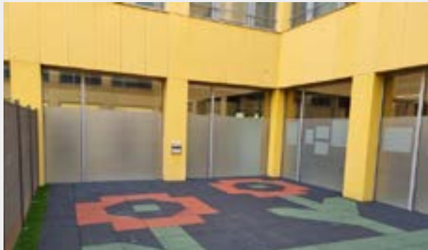
Cèche d'entreprise du centre hospitalier de Chalon-sur-Saône
