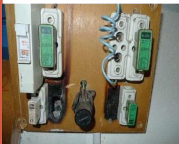
Branchements d'électricité vétustes
