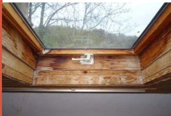
Absence de protection contre les infiltrations d'eau
