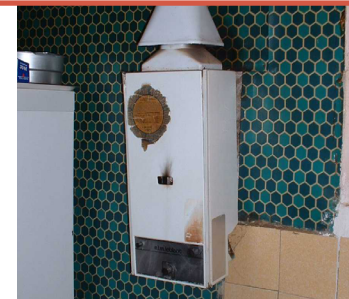
Absence de dispositif d'évacuation des gaz brûlés
